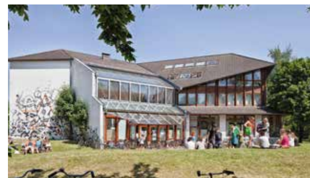
1984 wurde an der Großen Straße in Ottersberg der Neubau errichtet.
